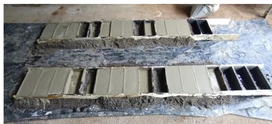
Fig. 2. Molde en madera. Fuente: autores
