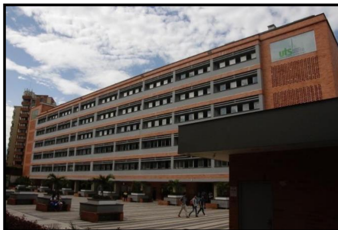
Fotografía No 3. Panorámica Edificio B
